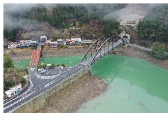
一般国道168号（五條新宮道路） 阪本工区 （五條市大塔町阪本内） 【R6年3月 開通】
